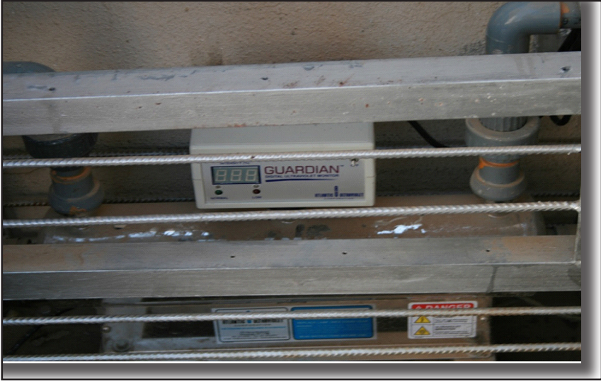
شكل (٩) تركيب جهاز الأشعة فوق البنفسجية (UV) للتخلص من المكروبات بالمياه الرمادية الناتجة عن الوضوء بمسجد عثمان بن عفان بالرياض بالموقع (الوابل وآخرون-١٤٣١هـ).
