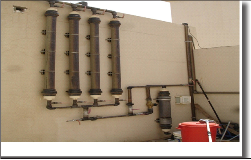
شكل (٨) الفلاتر الرملية الأربعة والفحم المنشط الذي يستخدم في نظام المعالجة بالموقع (الوابل وآخرون-١٤٣١هـ).
